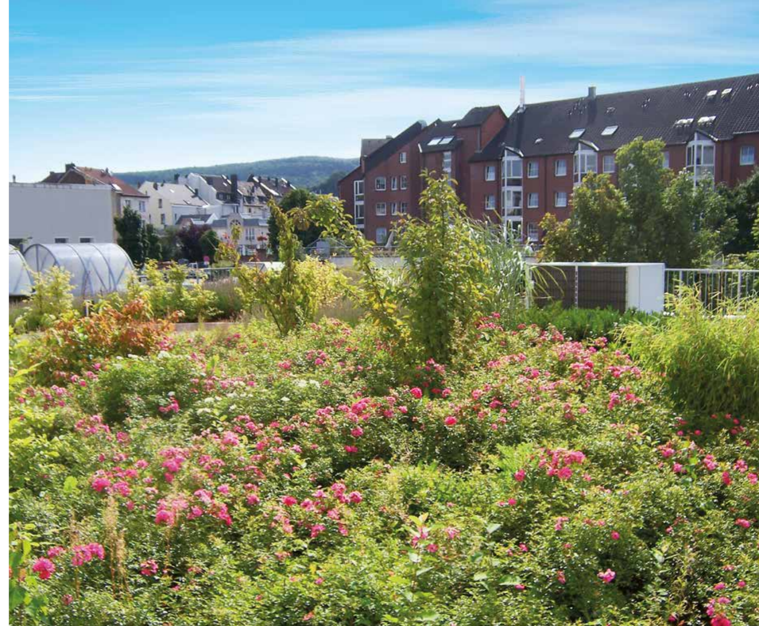
▲ Dachbegrünungen können Starkregenereignissen mit einem hohen Wasserrückhaltevermögen begegnen und damit auch die Kanalisation entlasten
