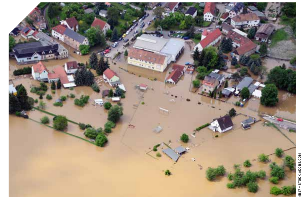
▲ Überflutungen wie im Juli 2021 in Deutschland zeigen das zerstörerische Potenzial von Starkregen
