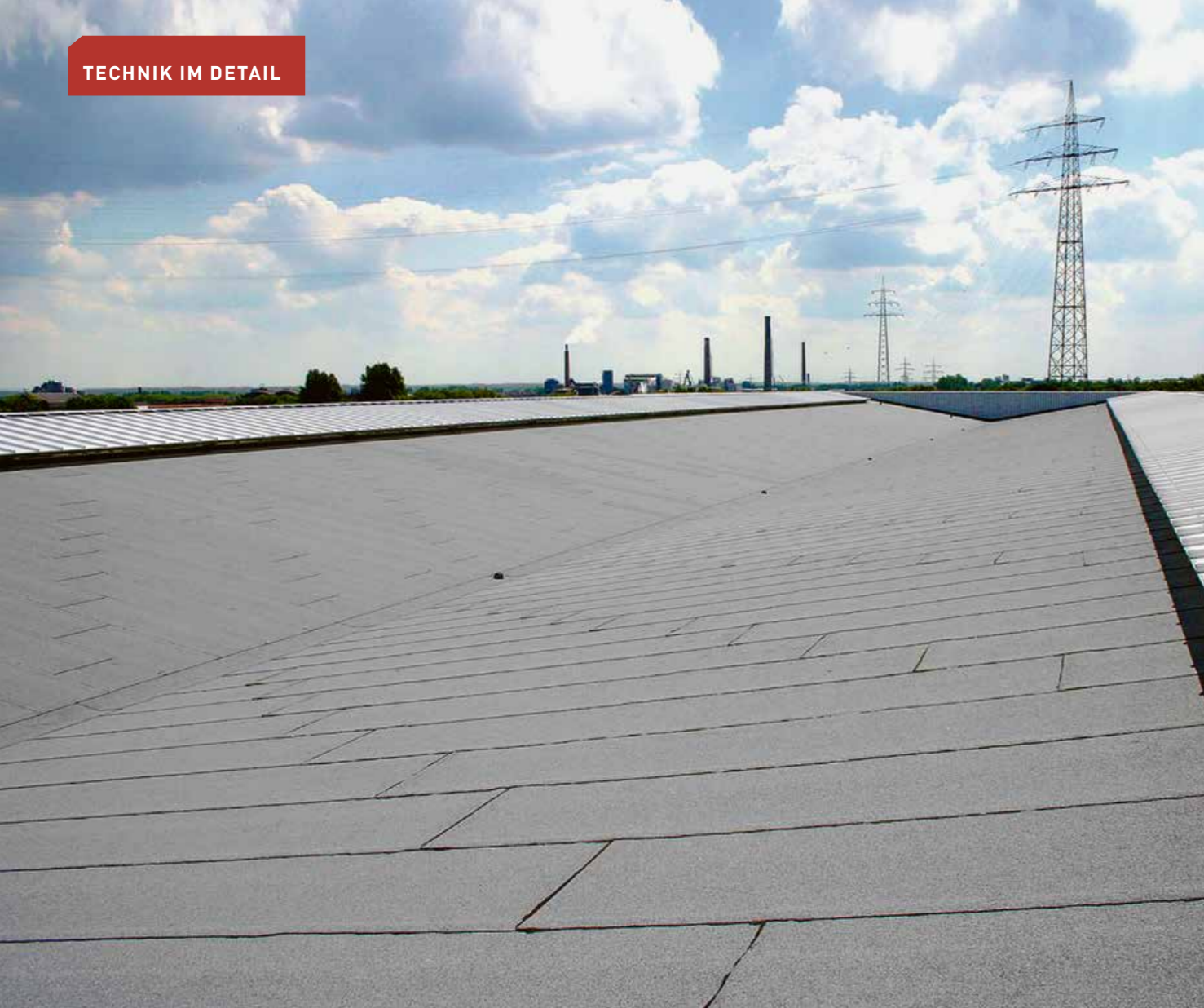
▲ Keine Chance für stehendes Wasser: Das Gefälle dieses Dachs beträgt deutlich mehr als fünf Grad und verhindert Pfützenbildung damit zuverlässig
