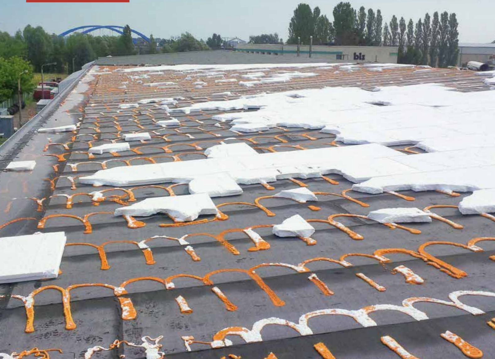
▲ Besser keine Schlangenlinien: Werden die Dämmstoffplatten unsachgemäß verklebt, können schwere Sturmböen die Abdichtung buchstäblich abschälen
