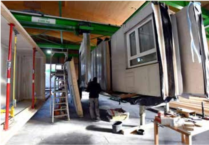
**In der Feldfabrik in Frankfurt werden die Wand-, Decken- und Bodenelemente zu Modulen zusammengesetzt**
