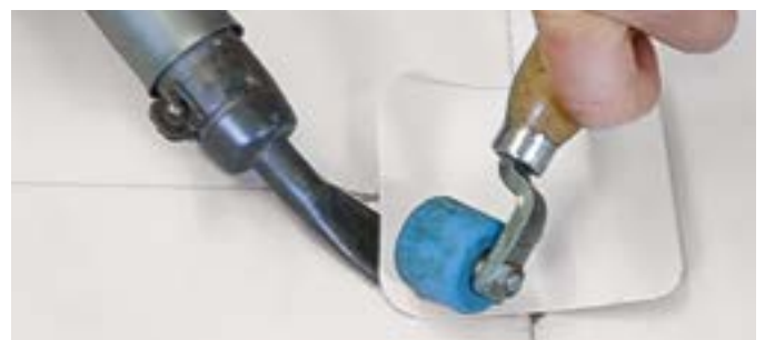
Überarbeitung einer Fehlstelle
