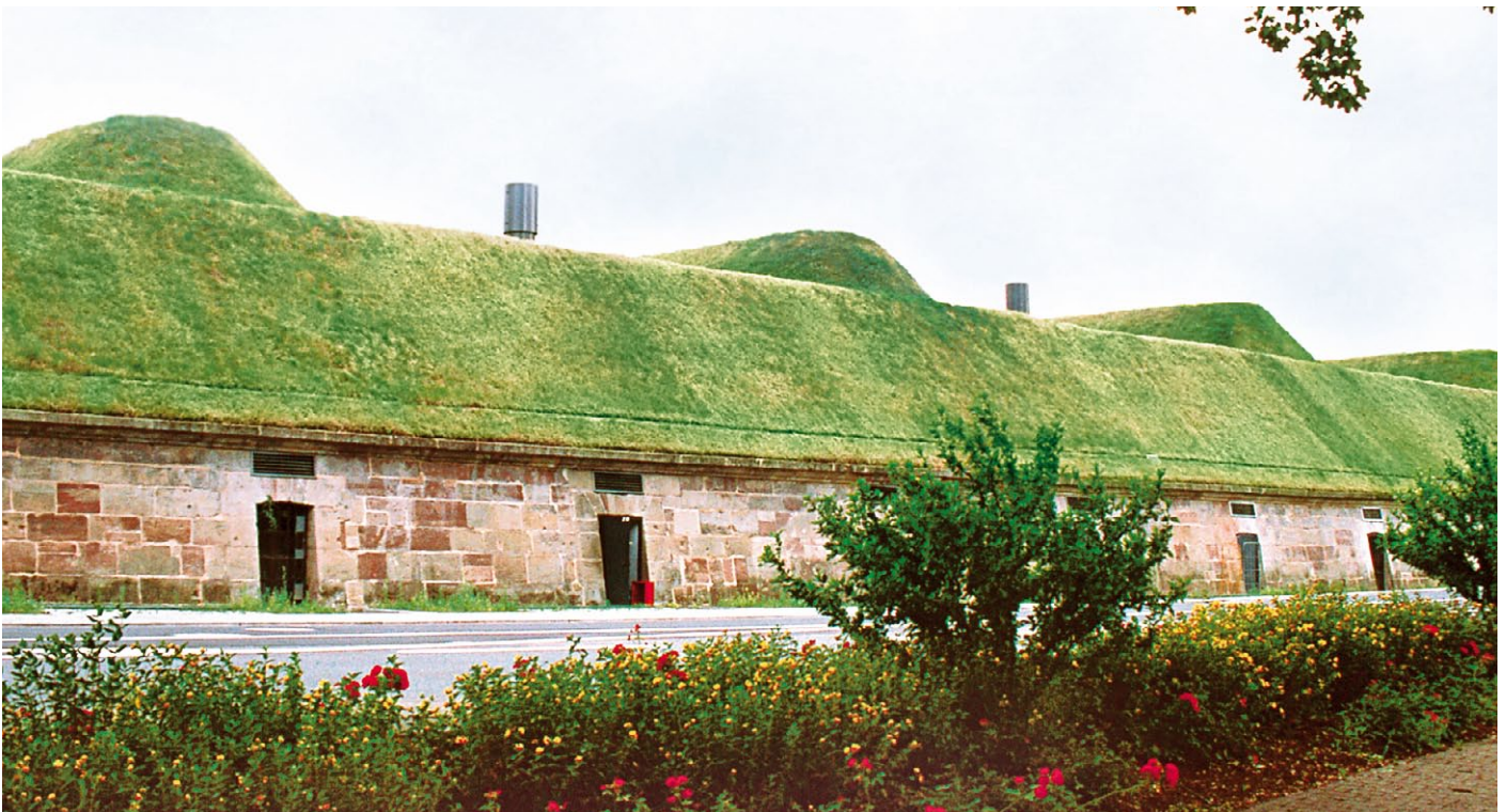
Kasematten am Kasemattenhof, Saarlouis
