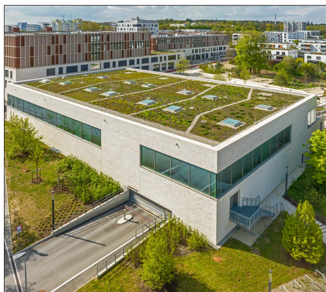
Ein Teil der Dachflächen ist begrünt, die höheren Flächen stehen als Aufstellort für eine Photovoltaikanlage zur Verfügung. © Oliver Heint
