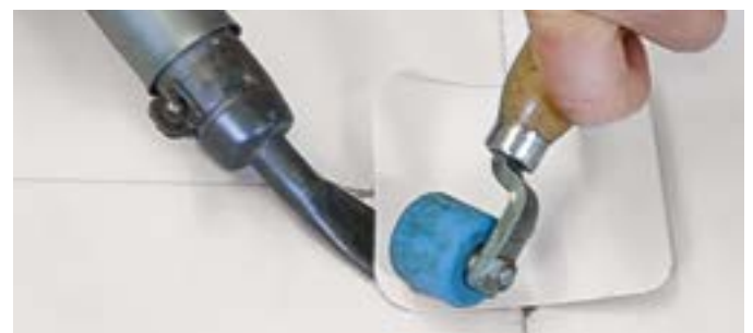
Überarbeitung einer Fehlstelle
