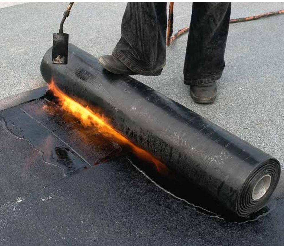
▲ Mit Flamme: Aufbringen einer Oberlagsbahn im Schweißverfahren
