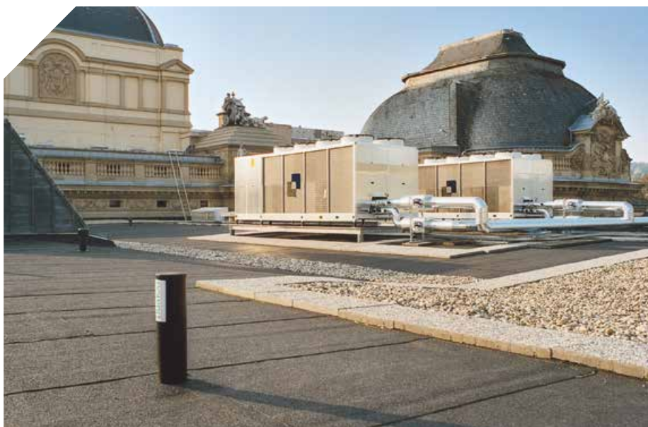
▲ Bewährt: Zwei Drittel aller Flachdächer in Deutschland sind mit Bitumenbahnen abgedichtet
