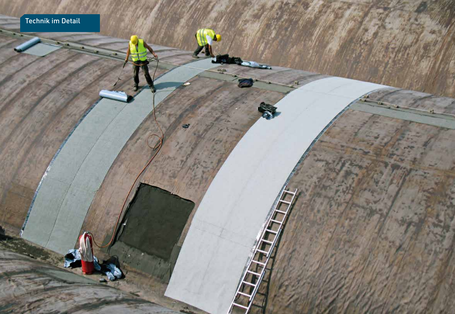
◀ Ein Beispiel aus der Praxis: Einlagige Überarbeitung eines Tonnendachs mit Kaltselfstklebmaterialien, die thermisch aktiviert werden
