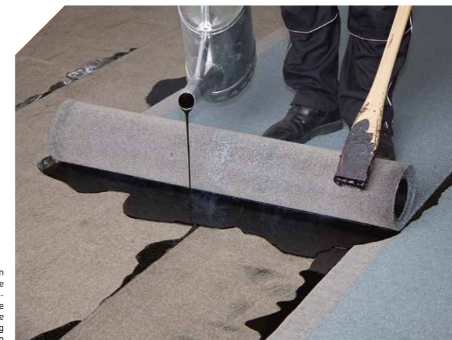
► Das Gießverfahren ist das älteste Verarbeitungsverfahren und bietet die schnelle, vollflächige Verlegung von Bitumenbahnen
