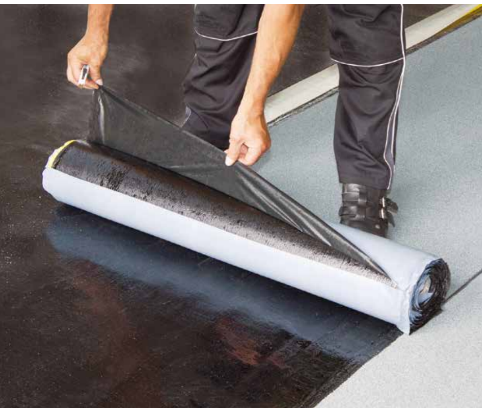
▲ Ohne Flamme: Verarbeitung einer selbstklebenden Polymerbitumenbahn
