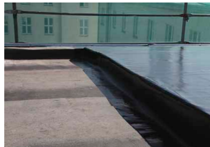
▲ Abschottungen bieten zusätzliche Sicherheit vor Wasserunterläufigkeit
