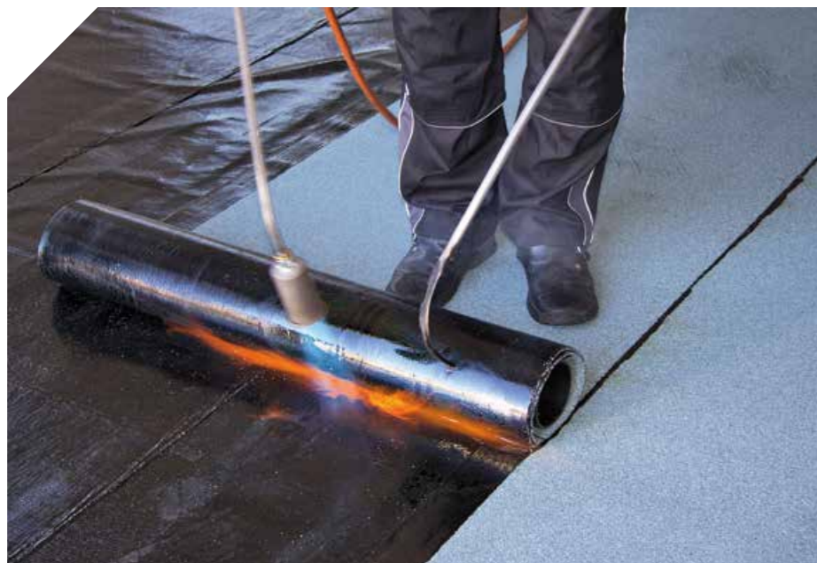
▲ Bitumenbahnen bieten dem Wind dank eines vollflächig verklebten Dachaufbaus keine Angriffsfläche
